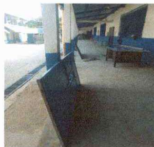
Foto 6: piso de aulas
