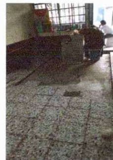
Foto 6: Puertas al nivel del piso
