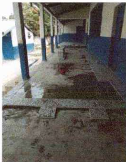
Foto 5: Puertas al nivel del piso
