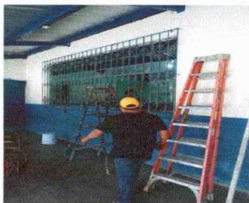
Foto 1: Ventanales por dentro de las aulas
