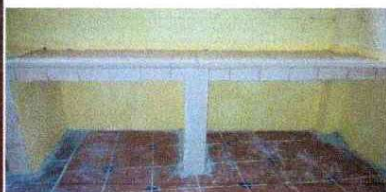
Foto 7 y 8: Cocina. Levantado de paredes para construcción de cocineta, a una altura de 0.85 m. x un ancho de 0.80 m. Fundición de Mesa de concreto con superficie de 9.24 m. con instalación de azulejo e instalación de piso cerámico.
