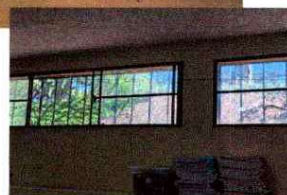
Foto 2, 3 y 4: Aula 2. Modificación de ventana fija a ventana corrediza.
