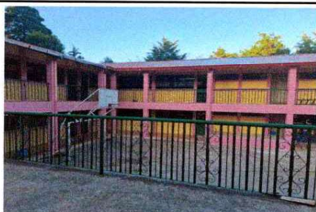
Foto 17: Refuerzo de Barandas del primer nivel.
