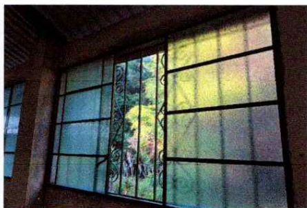
Foto 5: Aula 3. Instalación de ventana de metal corrediza e instalación de balcón.
