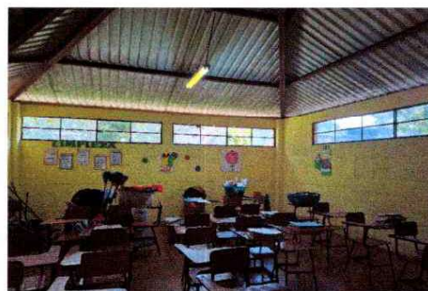
Foto 6: Aula 4. Modificación de ventana fija a ventana corrediza.
