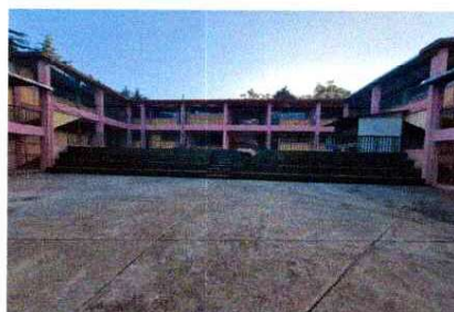
Foto 18: Pintura de graderio de cancha de básquetbol.
