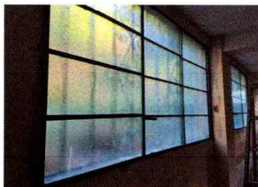
Foto 1: Aula 1. Instalación de ventana de metal corrediza e instalación de balcón.
