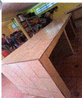
Foto 7 y 8: Cocina. Levantado de paredes para construcción de cocineta, a una altura de 0.85 m. x un ancho de 0.80 m. Fundición de Mesa de concreto con superficie de 9.24 m. con instalación de azulejo e instalación de piso cerámico.
