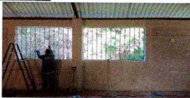
Foto 4 y 5: Aula 3. Demolición de pared para Apertura de ventana, instalación de balcón.
