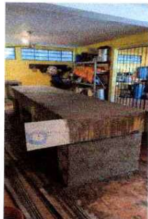
Foto 7 y 8: Cocina. Levantado de paredes para construcción de cocineta, a una altura de 0.85 m. x un ancho de 0.80 m. Fundición de Mesa de concreto con superficie de 9.24 m.
