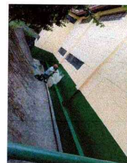
Foto 16y 17: Aplicación de pintura latex en 1,112 m2 a dos manos en pasillos y exterior del edificio escolar.
