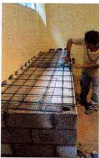
Foto 7 y 8: Cocina. Levantado de paredes para construcción de cocineta, a una altura de 0.85 m. x un ancho de 0.80 m. Fundición de Mesa de concreto con superficie de 9.24 m.
