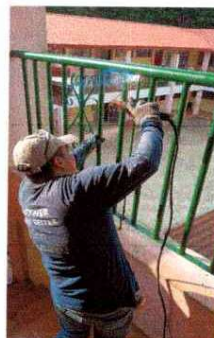
Foto 14: Refuerzo de banrandal perimetral del segundo nivel, agregando 330 barrotes de metal.
