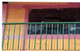
Foto 16y 17: Aplicación de pintura latex en 1,112 m2 a dos manos en pasillos y exterior del edificio escolar.
