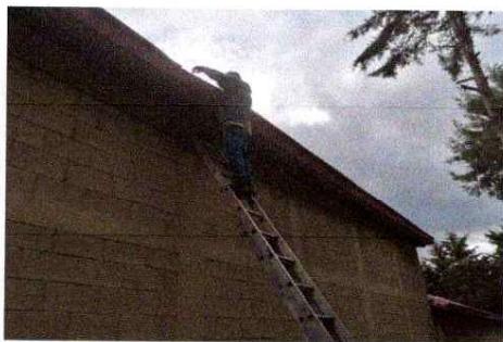
Foto 13. Enderezado de canal pluvial.
