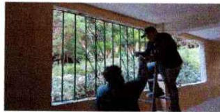
Foto 1 y 2. Aula 1. Demolición de pared para apertura de ventana, e instalación de balcón.
