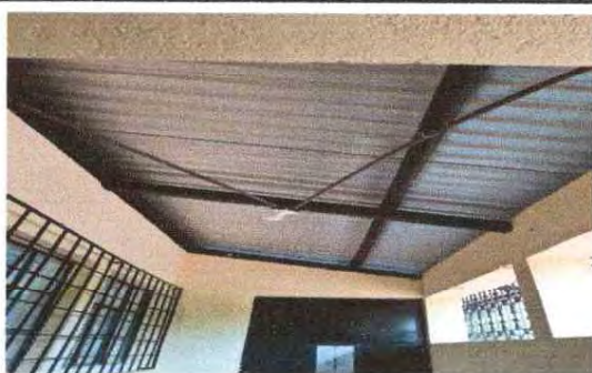
Foto 5: mantenimiento de valcones interiores
