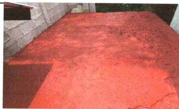
Foto 6: impermeabilización de loza de baños
