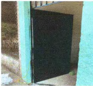
Foto 1: MANTENIMIENTO Y REPARACION DE PUERTAS DE METAL Y CAMBIO DE CHAPA
