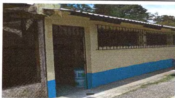
Foto 5: :mantenimiento de valcones y pintura en muro exterior
