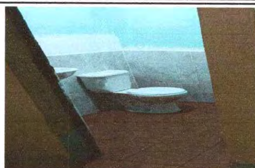
Foto 2: instalación de baño y lavamanos
