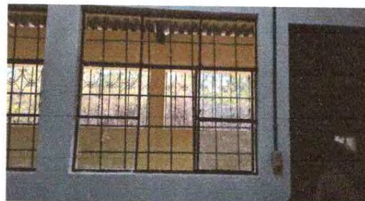
Foto 2: Mantenimiento de ventanales interiores
