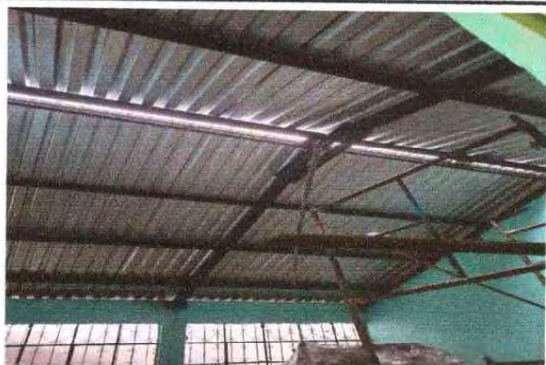
Foto 3: INSTALACIÓN DE LAMINA TROQUELADA
