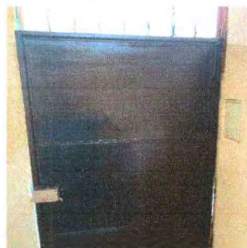
Foto 4: MANTENIMIENTO Y REPARACION DE PUERTAS DE METAL Y CAMBIO DE CHAPA
