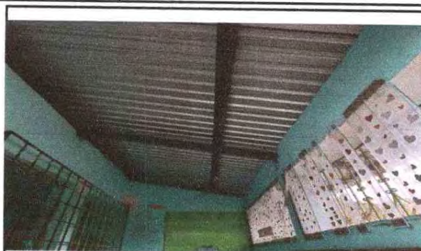
Foto 2: INSTALACIÓN DE LAMINA TROQUELADA
