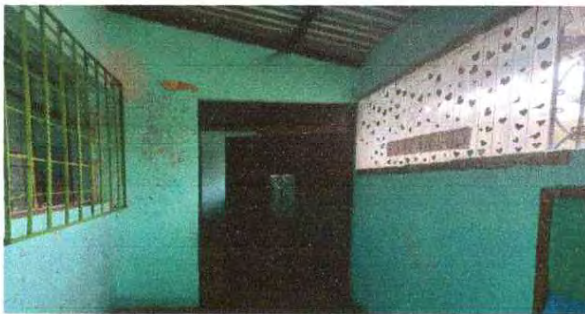
Foto 3: MANTENIMIENTO Y REPARACION DE PUERTAS DE METAL Y CAMBIO DE CHAPA
