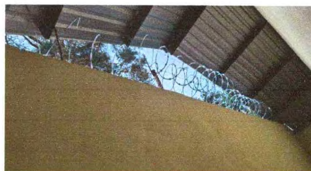
Foto 4: instalación de raizor en la terminación del muro perimetral
