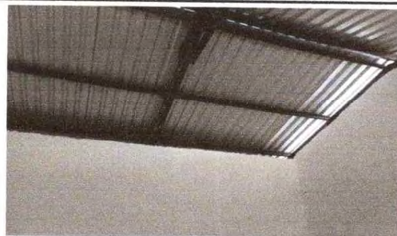
Foto 4: INSTALACIÓN DE LAMINA TROQUELADA
