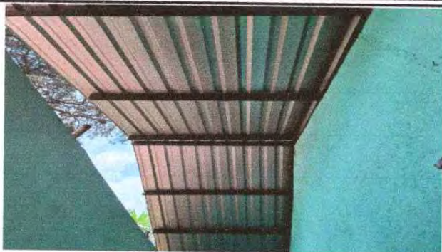
Foto1: INSTALACIÓN DE LAMINA TROQUELADA
