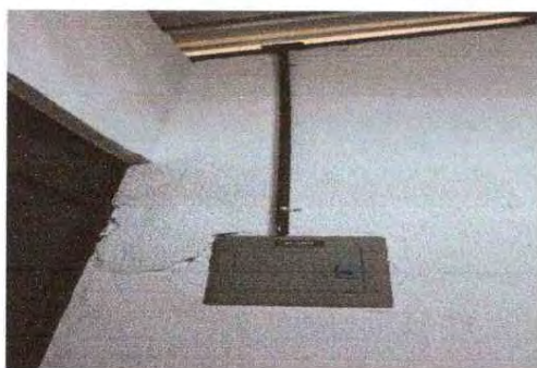
Foto 3: instalación de ducto y tablero de filipones
