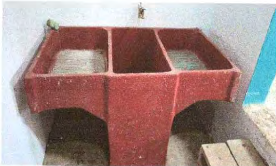
Foto1: instalación de pila de 2 lavaderos
