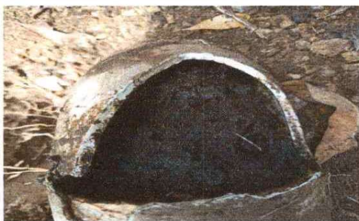
Foto 5: reparación e Drenajes de aguas negras
