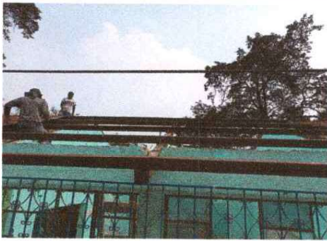
Foto 1: MANTENIMIENTO A ESTRUCTURA DE METAL
