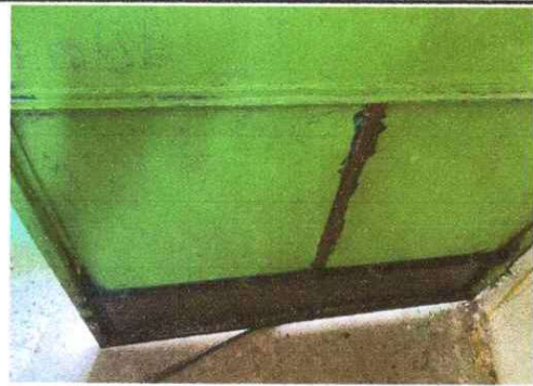
Foto 2: MANTENIMIENTO Y REPARACIÓN DE PUERTAS DE METAL
