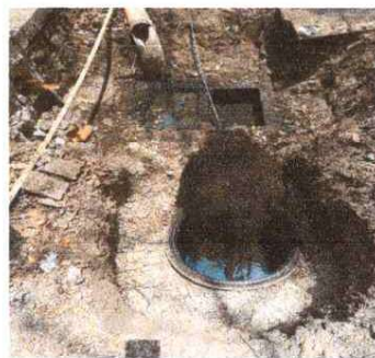
Foto 4: reparación e Drenajes de aguas negras
