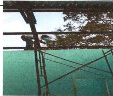
Foto 4: MANTENIMIENTO A ESTRUCTURA DE METAL
