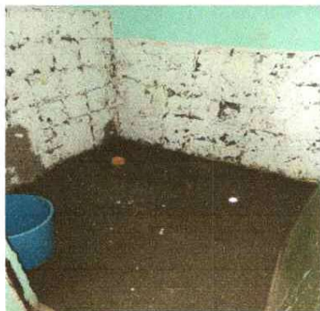
Foto1: reparación de loza de baño
