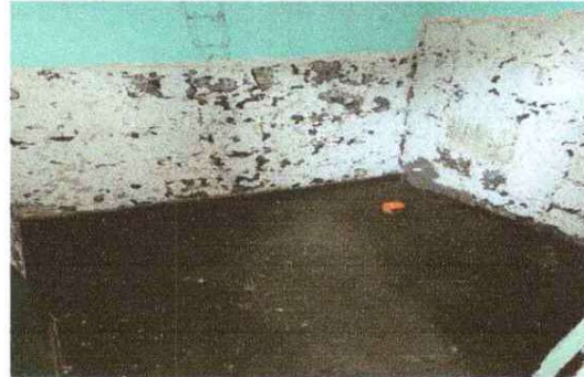
Foto 2: reparación de loza de baño
