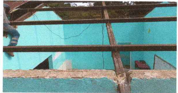
Foto 2: MANTENIMIENTO A ESTRUCTURA DE METAL
