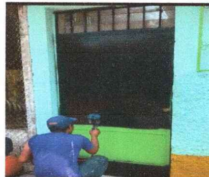
Foto 4: INSTALACIÓN DE LAMINA TROQUELADA
