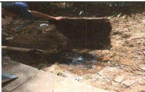
Foto 3: reparación e Drenajes de aguas negras
