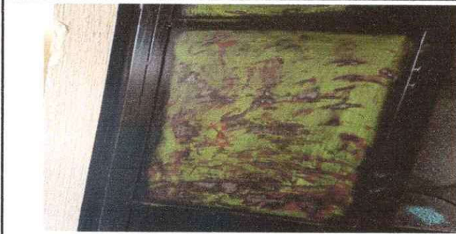
Foto 1: MANTENIMIENTO A PUERTAS DE METAL
