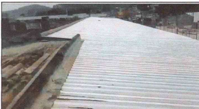
Foto 3: Filalización de la sustitución de lámina en el módulo 3 por lámina troquelada aluzinc calibre 26.
