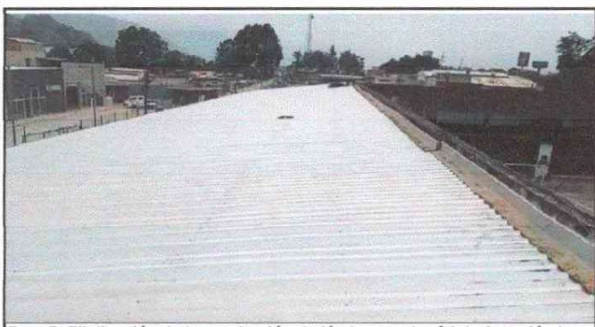
Foto 5: Filalización de la sustitución de lámina en el módulo 3 por lámina troquelada aluzinc calibre 26.
