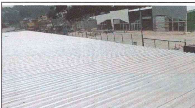
Foto 4: Filalización de la sustitución de lámina en el módulo 3 por lámina troquelada aluzinc calibre 26.
