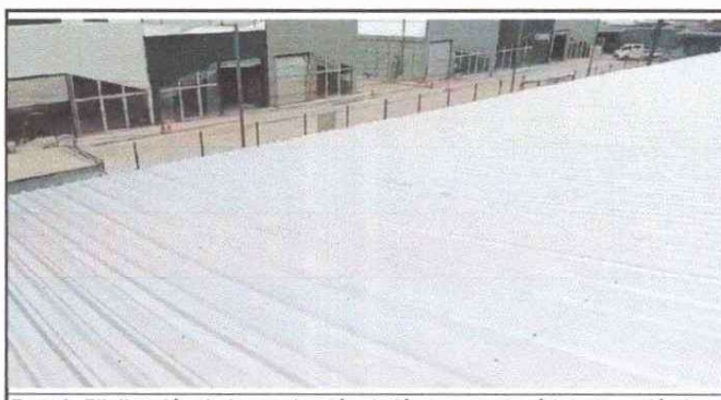
Foto 6: Filalización de la sustitución de lámina en el módulo 3 por lámina troquelada aluzinc calibre 26.
