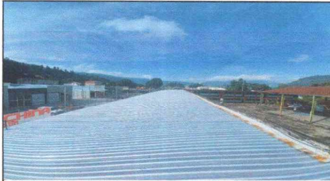
Foto 2: Filalización de la sustitución de lámina en el módulo 3 por lámina troquelada aluzinc calibre 26.
