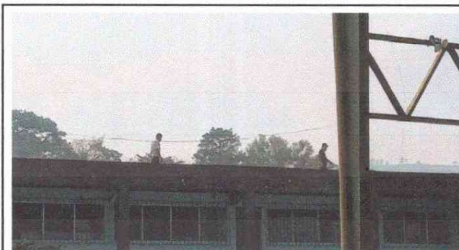
Foto 6: Proceso de Sustitución de lámina en el módulo 3 por lámina troquelada aluzinc calibre 26.
