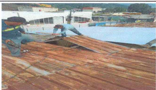
Foto 3: Proceso de Sustitución de lámina en el módulo 3 por lámina troquelada aluzinc calibre 26.
