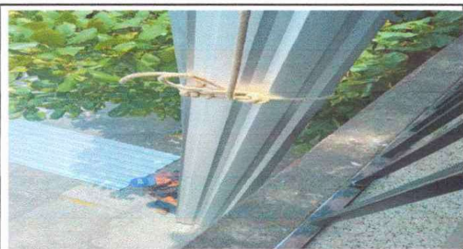
Foto 5: Proceso de Sustitución de lámina en el módulo 3 por lámina troquelada aluzinc calibre 26.
