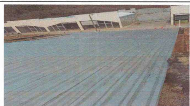
Foto 4: Proceso de Sustitución de lámina de una parte del módulo 3 por lámina troquelada aluzinc calibre 26.
