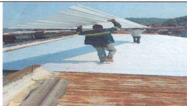
Foto1: Proceso de Sustitución de lámina en el módulo 3 por lámina troquelada aluzinc calibre 26.
