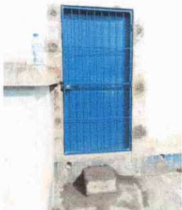
Foto 1: Fabricación de puertas de acceso , para salida de emergencia .
