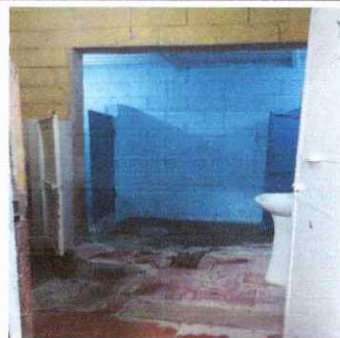
Foto 2: Ampliación de Sanitarios de niñas , ya que por la cantidad de niños , estos no se daban abasto .
