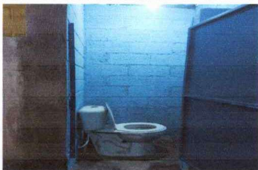
Foto 3: Ampliación de Sanitarios de niños , ya que por la cantidad de niños , estos no se daban abasto .
