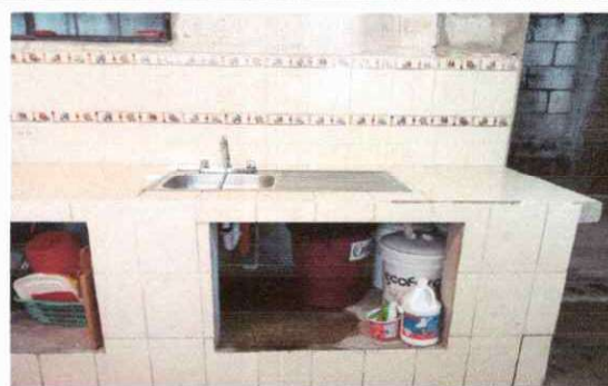
Foto 4: Habilitado de lavatrastes en cocina y apertura de bano para bodega de cocina.
