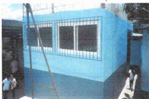
Fundición de cocina terminada
