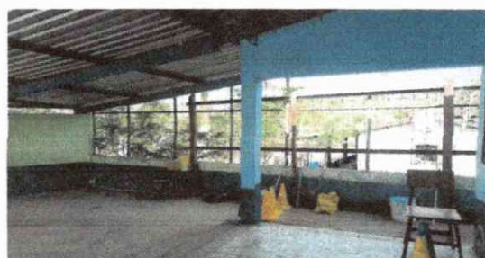
Pintura en proceso en el patio
