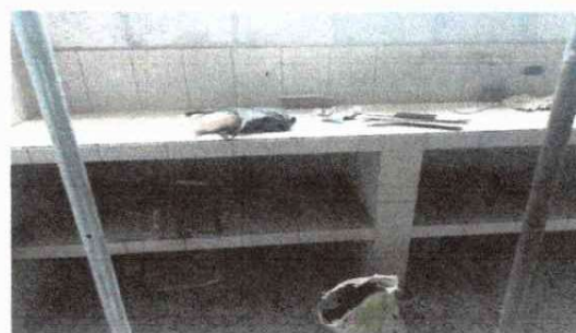
Ya se le coloco azulejo al mueble fundido en la cocina
