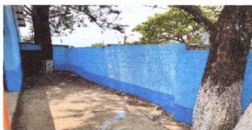
PINTURA EN MURO PERIMETRAL
