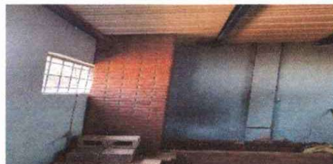
SUSTITUCION DE FUEGOS DE LEÑA CON CHIMENEA
