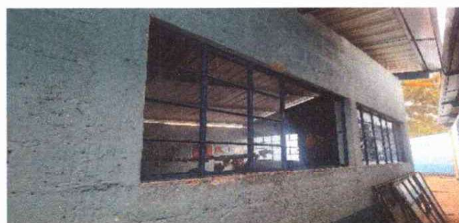
SUSTITUCION DE VENTANAS
