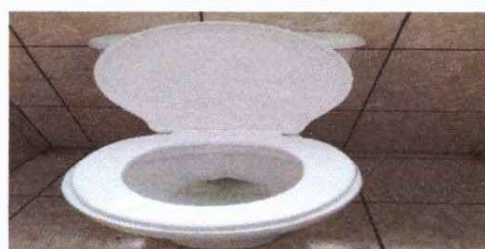
SUSTITUCION DE SANITARIOS
