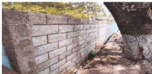
REPARACION DE MURO PERIMETRAL
