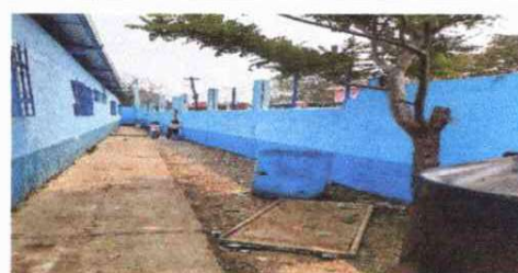
PINTURA EN MURO PERIMETRAL
