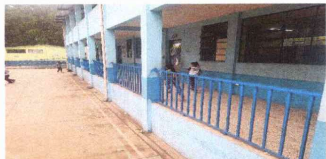
REPARACION DE BARANDA
