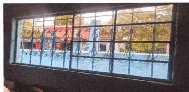
SUSTITUCION DE VENTANAS
