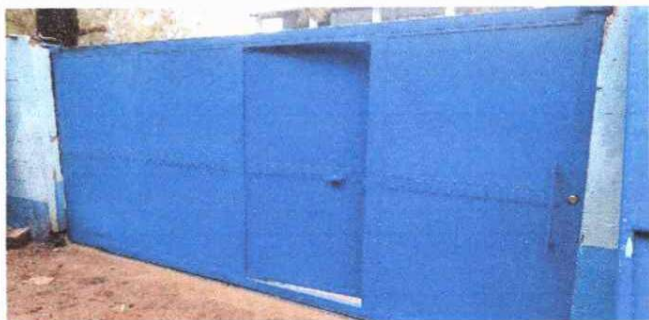
REPARACION DE PORTON
