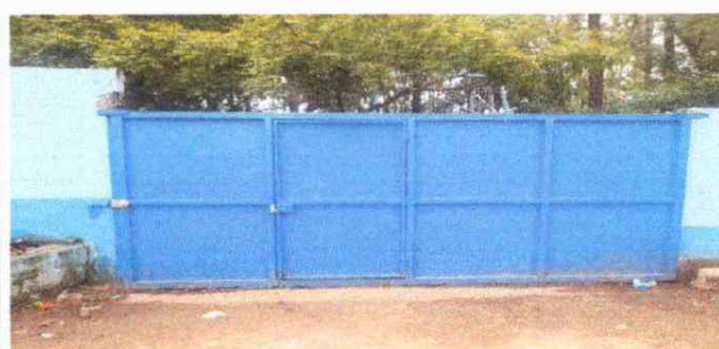
REPARACION DE PORTON
