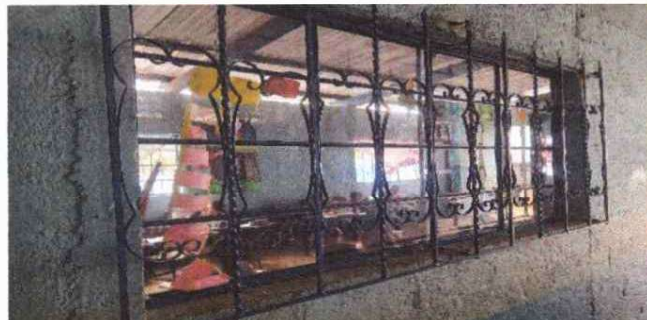
SUSTITUCION DE VENTANAS
