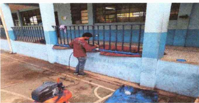
Mantenimiento a barandas
