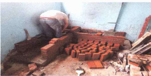
Sustitución de fogos de leña en cocina
