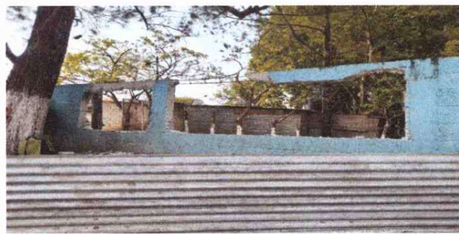
Demolición y levantado de muro perimetral
