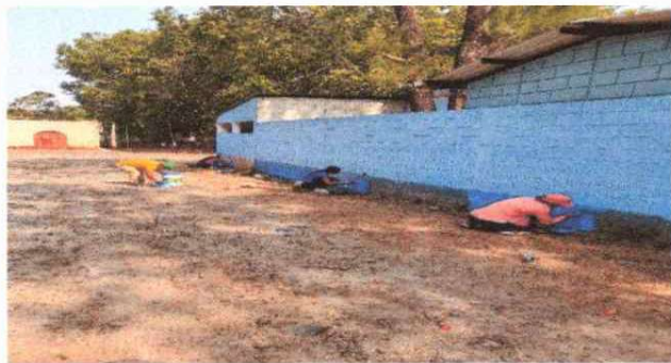
Aplicación de pintura en muro perimetral
