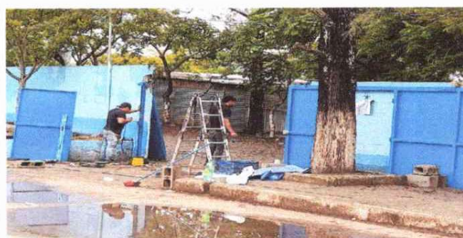
Reparación de portón
