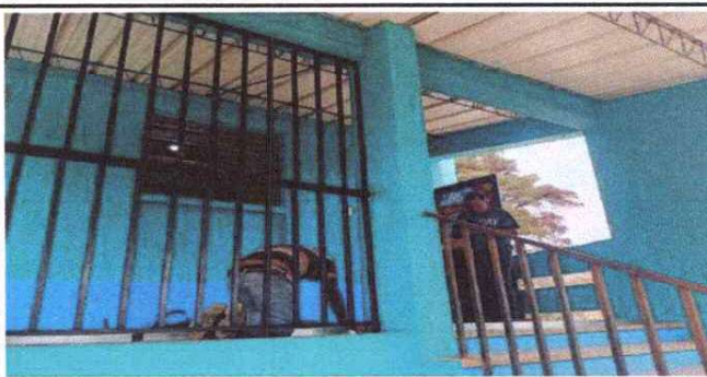
Foto 6: fabricacion e instalacion de reja de metal 2.35 X 2.30
