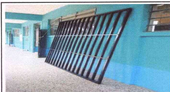
Foto 3: fabricacion e instalacion de puerta de reja de metal de 2.35 X 2.30 con tubo de 1 1/2 X 1 1/2 X 1, chapa Riel Stanley rodos staley
