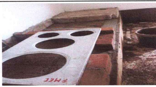
Foto 2: sustitucion de planca de metal de 3 hornillas
