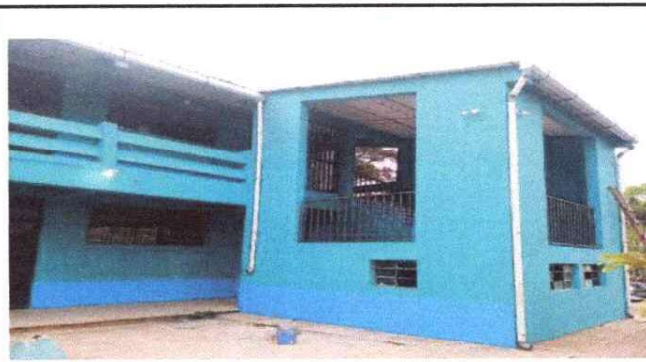
Foto 4: pintura de muros exteriores con pintura Celco Plus
