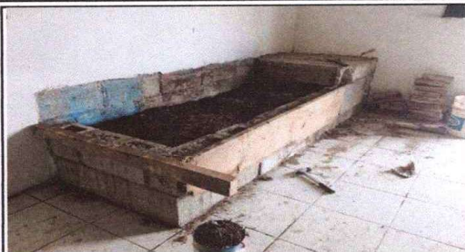
Foto1: mantenimiento de estufa Rural
