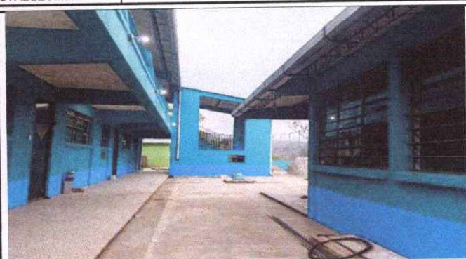
Foto1: pintura de muro exterior e interior con pintura Celco Plus
