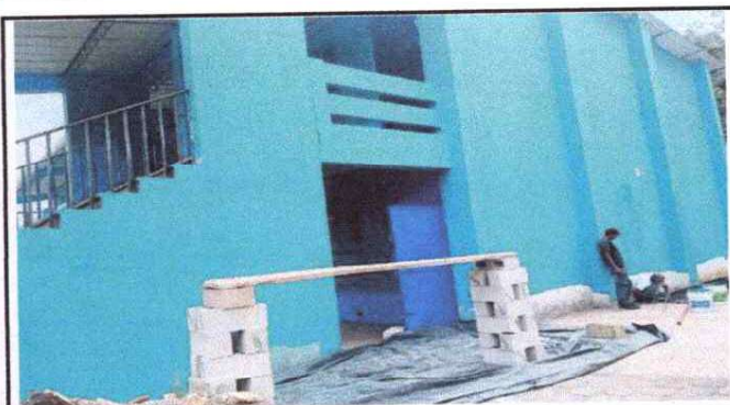
Foto 3: pintura de muro exterior e interior con pintura Celco Plus
