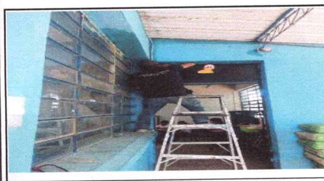
Foto 5: Pintura de muro exterior e interior con pintura Celco Plus
