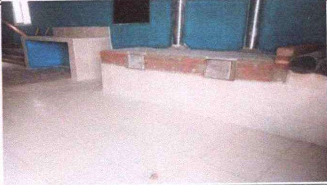
Foto 1: Instalacion de Plancha de cocina
