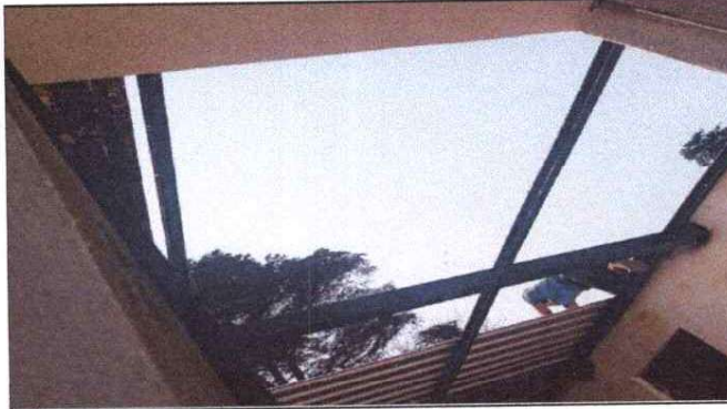
Foto 4: Intalacion de lamina Troquelada Aluzinc
