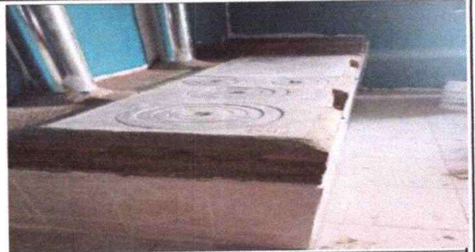
Foto 2: instalacion de plancha de cocina
