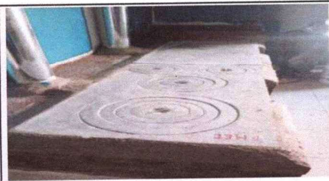
Foto 3: instalacion de plancha de cocina
