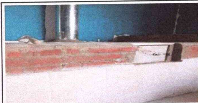
Foto 5: instalacion de plancha de cocina
