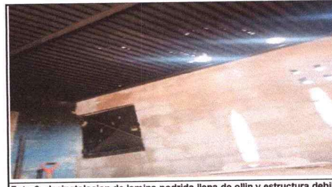
Foto 6: desinstalacion de lamina podrida llena de olin y estructura debil.
