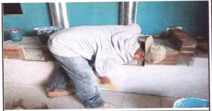
Foto 6: instalacion de plancha de cocina
