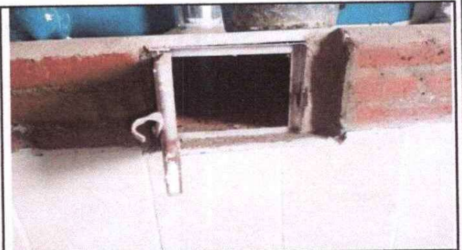
Foto 4: instalacion de plancha de cocina
