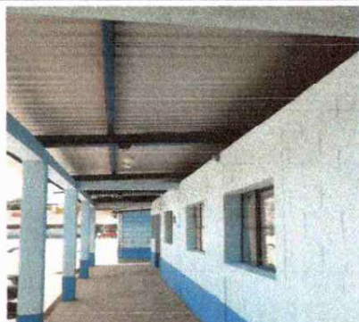
Foto 1: Cubierta de lámina, sustitución de lámina por lámina troquelada zinc calibre 26
