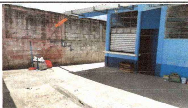
Foto 6: Losa De Patio: Reparación De Red De Drenaje y Agua Potable
