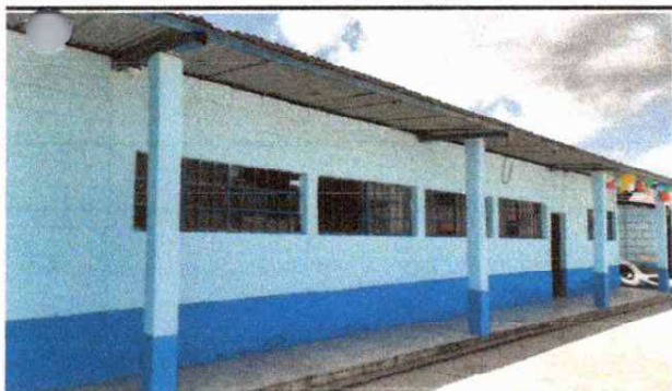
Foto 5: Pintura en muros exteriores e interiores 5 aulas
