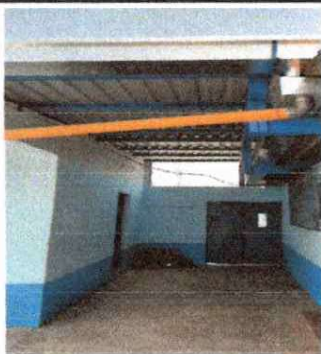
Foto 3: Canales y Bajada de agua Pluvial
