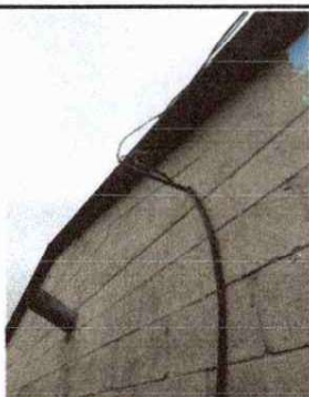
Foto 5: Reparación de Sistema Eléctrico
