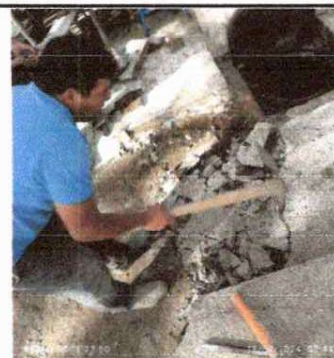
Foto 6: Reparación de drenaje de baños
