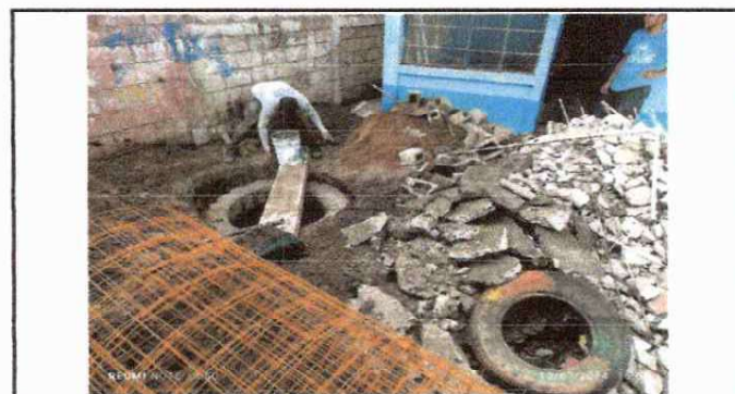
Foto 6: Losa De Patio: Reparación de planchas de concreto de patio
