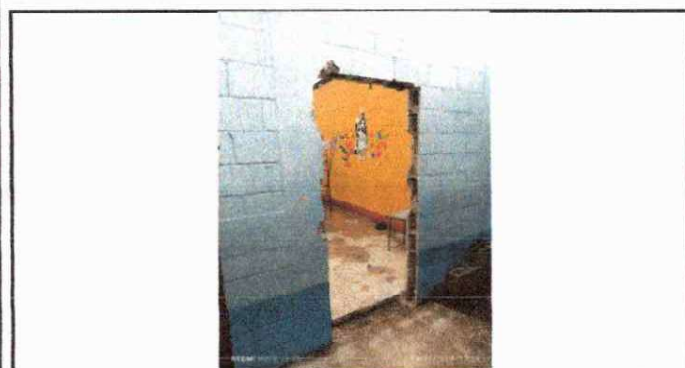
Foto 3: Puertas de metal: Mantenimiento a estructura
