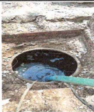
Foto 1: Limpieza de Fosa Séptica
