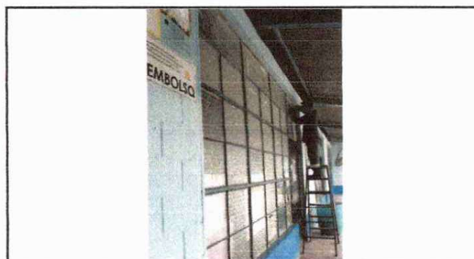
Foto 4: Ventanas: Mantenimiento a estructura de metal, sustitución de vidrios.
