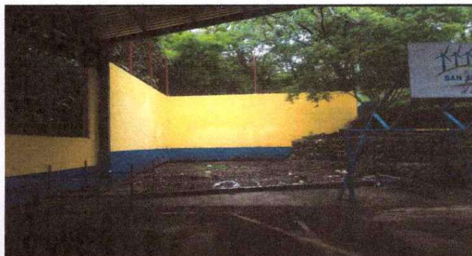
AMPLIACIÓN DE PARED DE MURO PERIMETRAL CON BLOCK Y ELECTROMALLA
