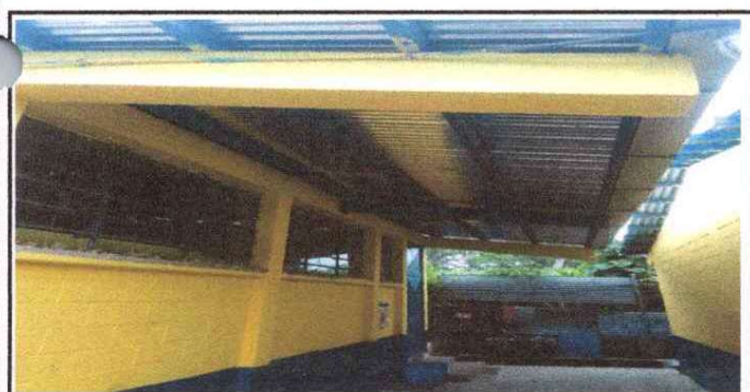
CAMBIO DE LAMINA ACANALADA EN SALÓN DE CLASES DE PREPARATORIA
