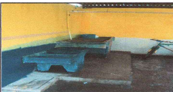
CONSTRUCCIÓN DE BANQUETA PARA PILAS
