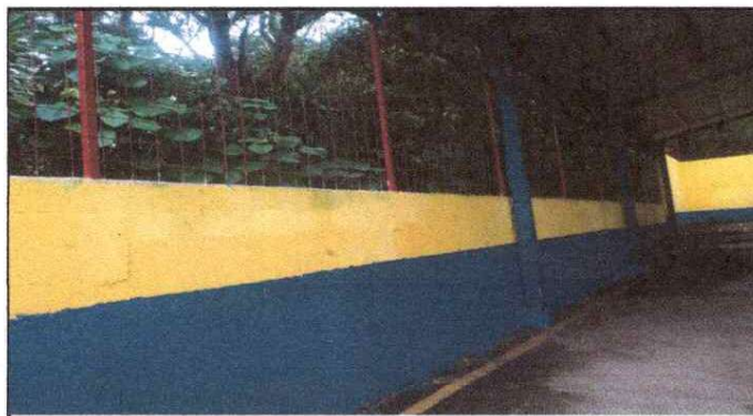
AMPLIACIÓN DE PARED DE BLOCK Y LEVANTADO CON ELECTROMALLA
