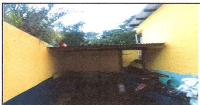
CONSTRUCCIÓN DE TECHO DE GALERA DE PILA, INTRODUCCIÓN DE DRENAJES, CERNIDO Y LEVANTADO DE PARED DE FONDO CON BLOCK, CAJA DE REGISTRO DRENAJE, CONSTRUCCIÓN DE BANQUETA
