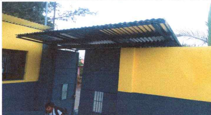
INSTALACIÓN DE TECHO PARA INGRESO PRINCIPAL
