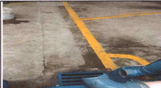
CONEXIÓN DE DRENAJES AGUA PLUVIAL DE TECHO DE CANCHA POLIDEPORTIVO, Y MODULO 2 DE SALONES DE CLASE. FUNDICIÓN DE CUNETAS EXISTENTES
