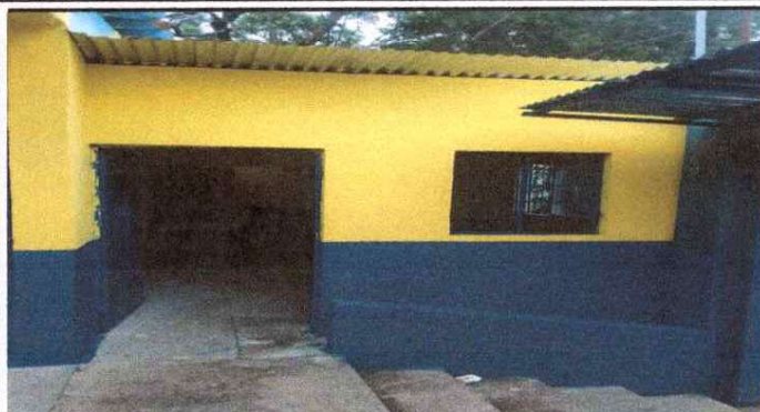
AMPLIACIÓN DE COCINA, INSTALACIÓN DE PUERTA VENTANA DE METAL, DRENAJE, VENTANA DE PVC, INSTALACIÓN DE TECHO DEL 50 % BALCÓN Y CERNIDO
