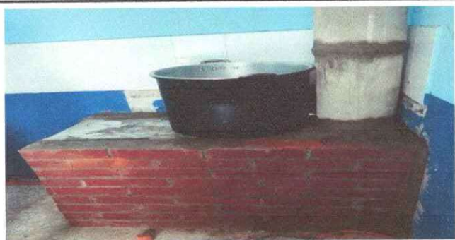
Foto 1: SUSTITUCIÓN Y REPARACIÓN DE COCINA (DE LEÑA)
