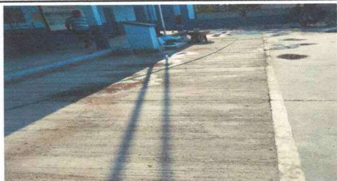
Foto 3: LOSA DE PATIO
