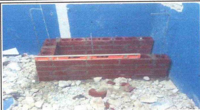
Foto 1: SUSTITUCIÓN Y REPARACIÓN DE COCINA (DE LEÑA)
