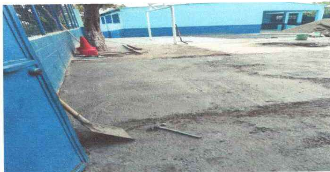
Foto 3: LOSA DE PATIO
