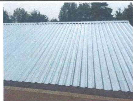
Foto 5: Cambio techo modulo 2
