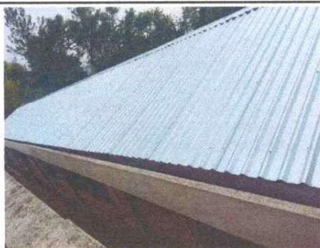
Foto 3: Cambio de techo módulo 2
