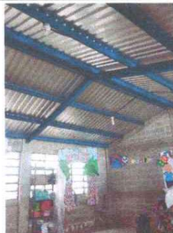
Foto 2: Cambio de techo módulo 1
