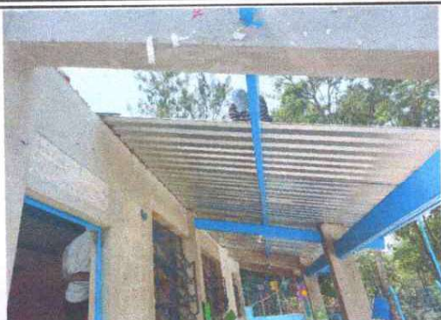
Foto 1: Cambio de techo de corredor
