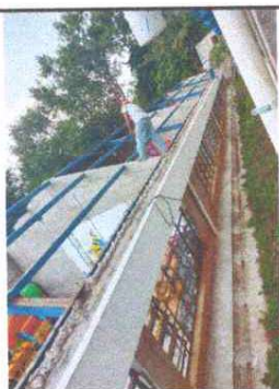
Foto 3: Cambio de techo módulo 2
