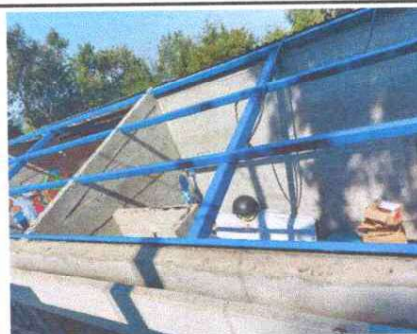
Foto 6: Cambio techo módulo 1
