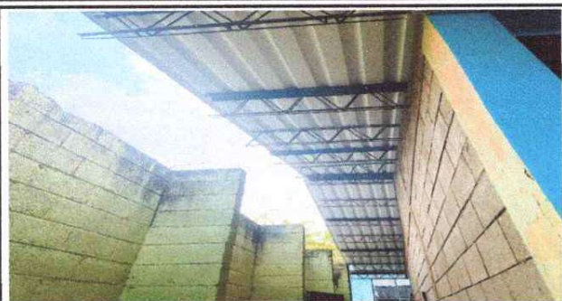
FOTO 1: Lámina troquelada color blanco calibre 547 M2, para sustituir techo de aulas y corredores.
