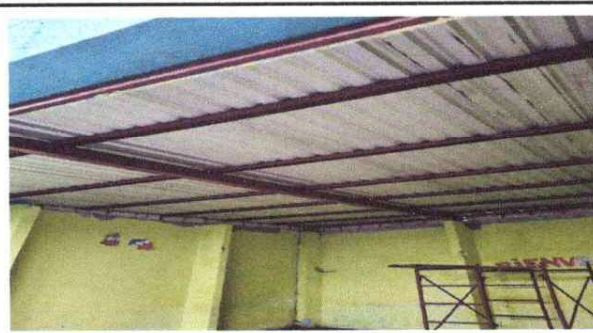
FOTO 2: Lámina troquelada calibre 547 M2, para sustituir techo de salones de clases de preprimaria.
