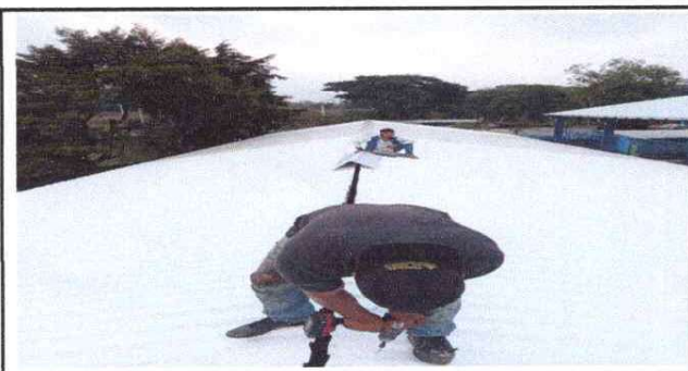
FOTO 3: Colocación de costaneras sobre estructura tipo joist, para anclaje de nuevas láminas. 547 M2.
