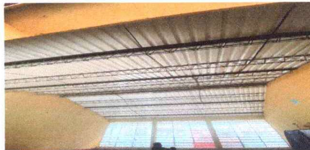
FOTO 4: Lámina troquelada color blanco calibre 547 M2, en los salones de clase.
