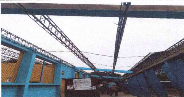
FOTO 5: Desmontaje de techo de duralita de los corredores, con apoyo de los padres de familia 547 M2.
