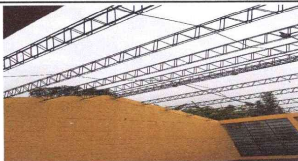
FOTO 6: Salones de clase con lámina de duralita desmontada 547 M2.
