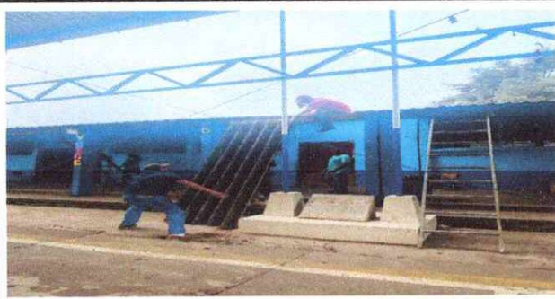
FOTO 1: Desmontaje de techo de duralita de los salones de clases, con apoyo de los padres de familia 547 M2.
