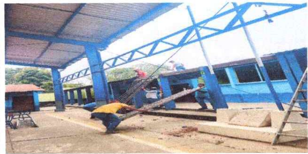
FOTO 2: Desmontaje de techo de duralita de los salones de clases, con apoyo de los padres de familia 547 M2.
