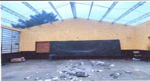
FOTO 3: Desmontaje de techo de duralita de los salones de clases, 547 M2.
