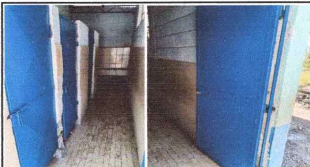
Foto 4: Reposición de puerta principal y reparación de puerta de baño
