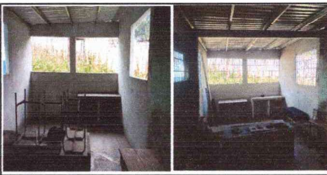
Foto 5: Reparación y sustitución de área de cocina
