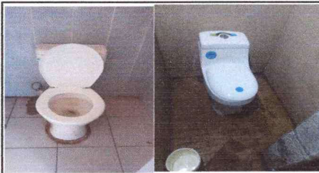
Foto 2: Sanitarios y accesorios
