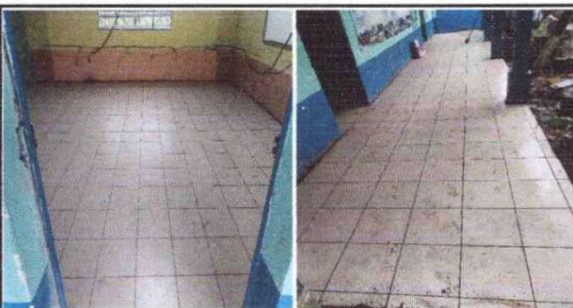
Foto 3: Sustitución de Piso de granito por azulejo
