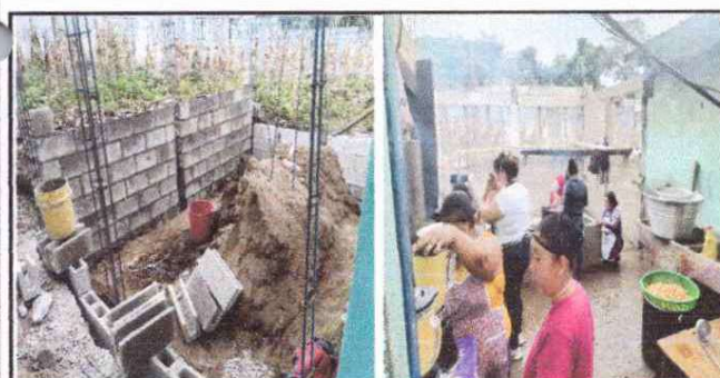
Foto 5: Reparación y sustitución de área de cocina
