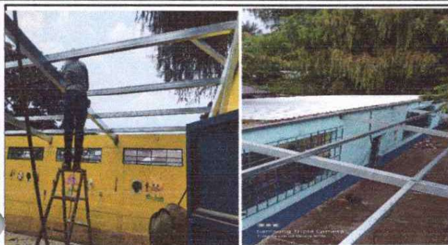
Foto 1: Estructura y cubierta de Lamina
