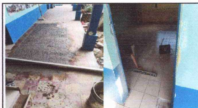
Foto 3: Sustitución de Piso de granito por azulejo
