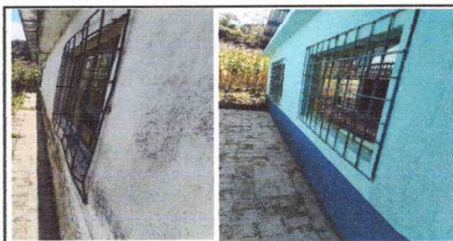
Foto 6: Mantenimiento de Balcon de clases
