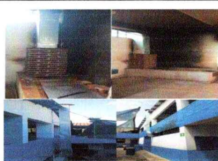
Foto 6: trabajos finalizados ahora se cuenta con plancha de metal para fogón con puerta y chimenea de alucin de 7.50 m de altura
