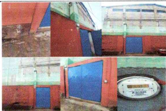
Foto 1: se concluyo el trabajo del contador a la nueva caja RH que se reubico dentro del edificio, ordenamiento de cableado y se polarizo el edificio y centro de computación.
