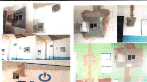
Foto 2: trabajo de reubicación- sustitución de tableros, cambio de flipones, cableado ducto, conyevará trabajo de albañilería, picado, rellenado, tallado y pintura de las áreas trabajadas.
