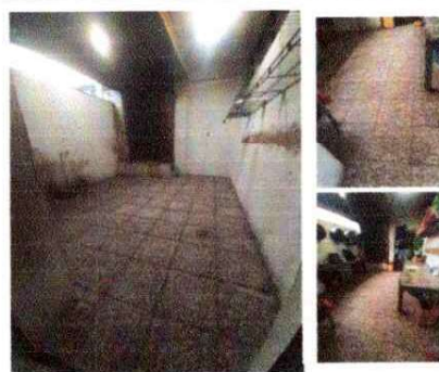
Foto 10: Piso de granito instalado en el área de cocina, se realizó nivelación del suelo.
