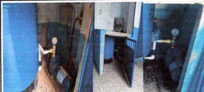
Foto 8: trabajo finalizado de sustitución de tubería de bomba de agua,
