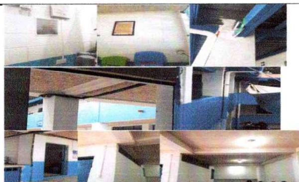
Foto 3: trabajo de cableado y ducto para bombillas, apagadores, cables que se encontraban al aire o expuestos
