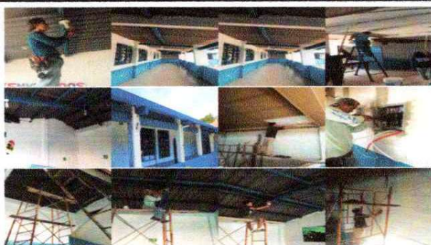
Foto 5: trabajo para la sustitución de flafoneras, 114 focos de interior 4 bombillos de exterior led 40 wt, 3 bombillos de exterior led 50 wt, apagadores, pantallas led hacia el patio
