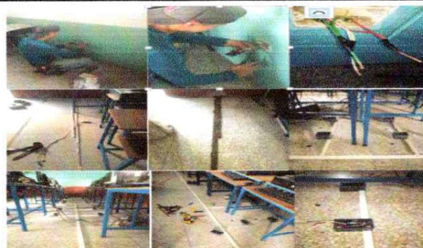
Foto 4: trabajo en las sustitución de todos los tomacorrientes del edificio, incluyendo la instalación nueva de todos los tomacorrientes para aula de computación
