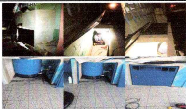
Foto 9: fabricación e instalación de 1 puerta de metal con chapa para el área de bomba de agua, 2 puertas de metal y 2 tapaderas de metal para contenedor de basura
