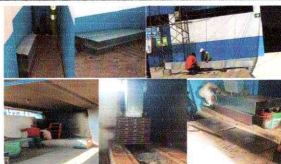
Foto 6:1) trabajo para sustitución de parilla improvisada a plancha de metal para fogón 2) Chimenea de lamina de alución de 7.5 m de altura y puerta del fogón
