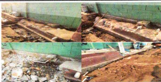
Foto 7: trabajo sustitución de llave de paso de agua potable ubicado sobre la 1era. Calle de la zona 2, se escabó 2.80m de muro perimetral debido a fuga en tubería. Se reubicó registro.
