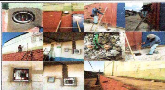
Foto 1: se inició con sustitución y detalles del contador, se cambio caja RH al interior del edificio, se polarizo la red electrica del edificio y aula de computación colocando 2 varillas de cobre
