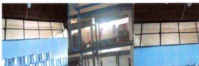
Foto 11: se realizó la instalación de vidrios en cocina y 1 aula.
