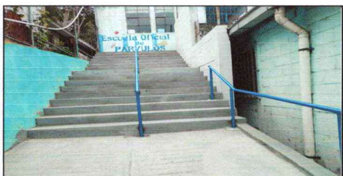
FOTO 5: RAMPA DE ACCESO PRINCIPAL
