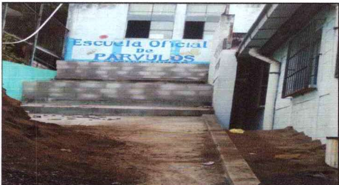
Foto 3: RAMPA DE ACCESO PRINCIPAL
