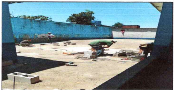
Foto 4: NIVELACION PATIO PRINCIPAL
