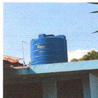
Foto 2: Modulo 18 sustitución de tinacos
