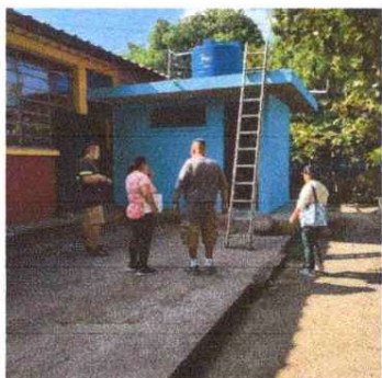
Foto 1: Modulo 18 sustitución de tinacos
