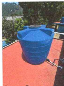
Foto 2: Modulo 3 impermealización de losa
