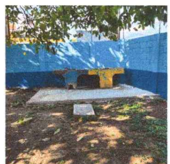
Foto 5: Modulo 19 instalación de pila
