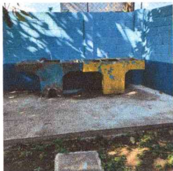
Foto 3: Modulo 16 reparación losa de patio
