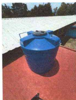
Foto 3: Modulo 3 impermealización de losa
