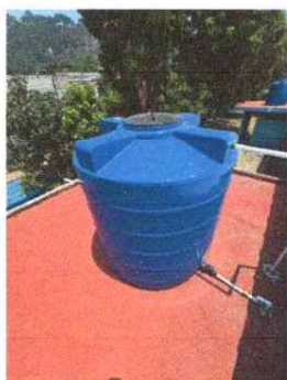
Foto 3: Modulo 18 sustitución de tinacos
