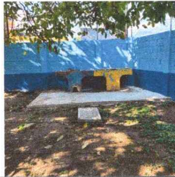
Foto 2: Modulo 16 reparación losa de patio
