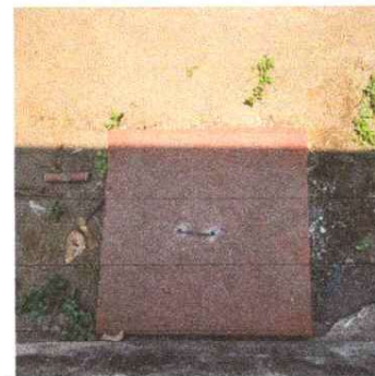
Foto 4: Modulo 14 reparación de red de drenaje
