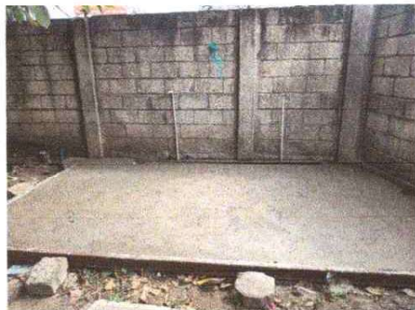
Foto 1: Modulo 16 reparación losa de patio
