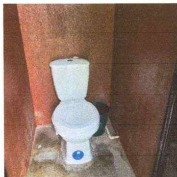
Foto1: Modulo 10 cambio de accesorios de 3 sanitarios
