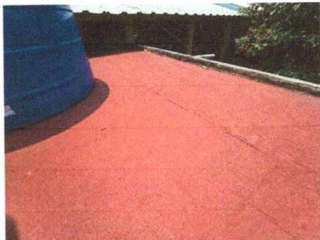
Foto 1: Modulo 3 impermealización de losa
