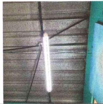
Foto 6: Modulo 17 sustitución de lámparas por lámpara led dirección
