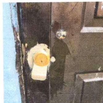
Foto 6: Modulo 4 Sustitución de chapas de cocina
