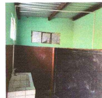
Foto 5: Modulo 14 reparación de red de agua potable
