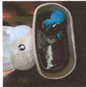
Foto 2: Modulo 10 cambio de accesorios de 3 sanitarios
