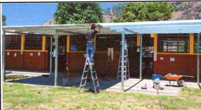
Foto 4: Modulo 19 sustitución de estructura metalica y lamina en patio
