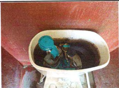
Foto 1: Modulo 10 cambio de accesorios de 3 sanitarios
