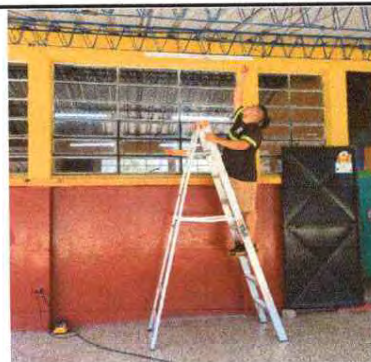
Foto 4: Modulo 17 sustitución de lámparas por lámpara led corredor
