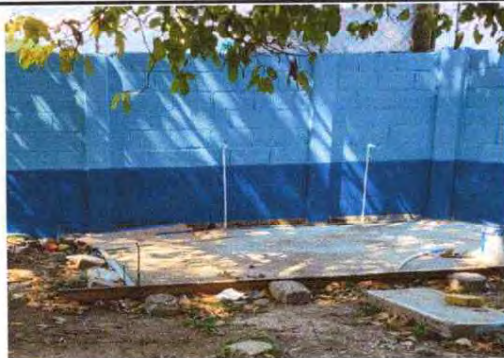
Foto 2: Modulo 16 reparación losa de patio
