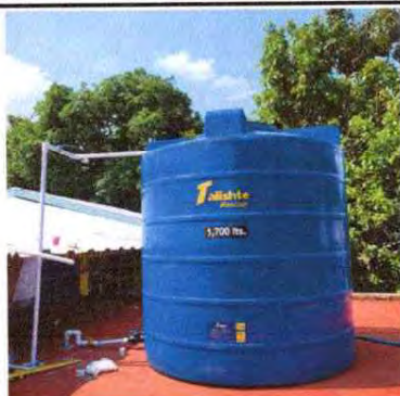
Foto 3: Modulo 18 sustitución de tinacos
