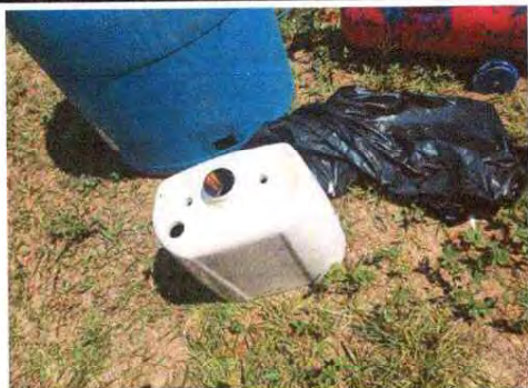
Foto 3: Modulo 10 cambio de accesorios de 3 sanitarios
