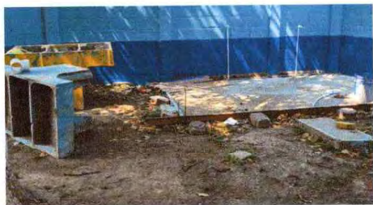
Foto 5: Modulo 19 Instalación de pila
