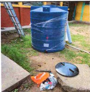
Foto 1: Modulo 18 sustitución de tinacos
