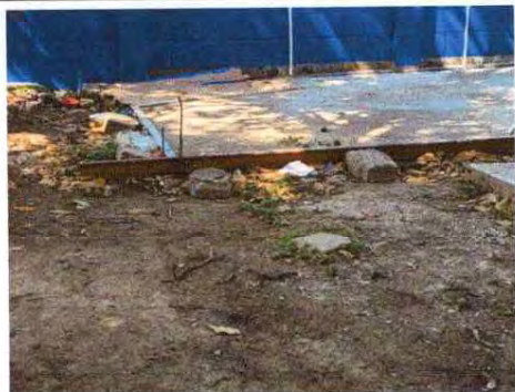
Foto 1: Modulo 16 reparación losa de patio
