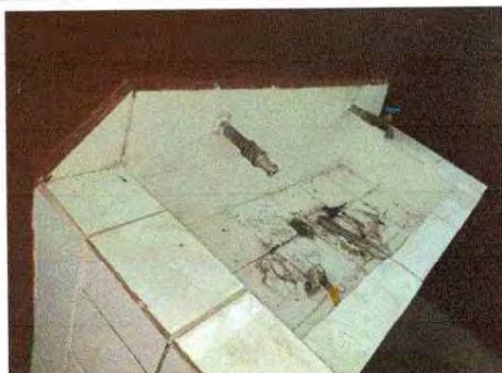
Foto 5: Modulo 14 reparación de red de agua potable
