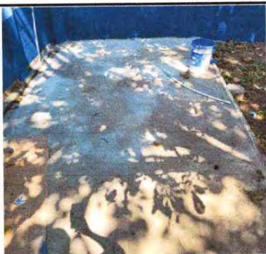
Foto 3: Modulo 16 reparación losa de patio
