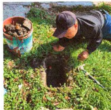
Foto 4: Modulo 14 reparación de red de drenaje
