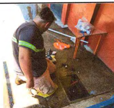
Foto 6: Modulo 14 reparación de caja de registro
