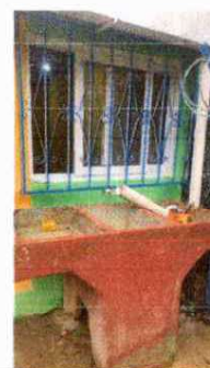
Foto 6: Instalación de ventana y colocación de pila en el are de patio.
