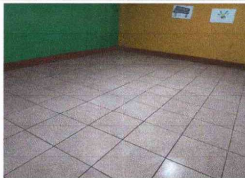
Foto 2: colocacion de piso ceramino en la aula numero 1, 55m cuadrados
