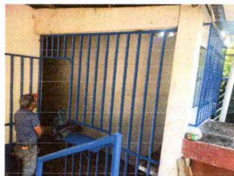
Foto 2: Instalación de reja y puerta en el area de cocina.
