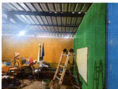
Foto 3: Aplicación de pintura en las paredes de toda la escuela.
