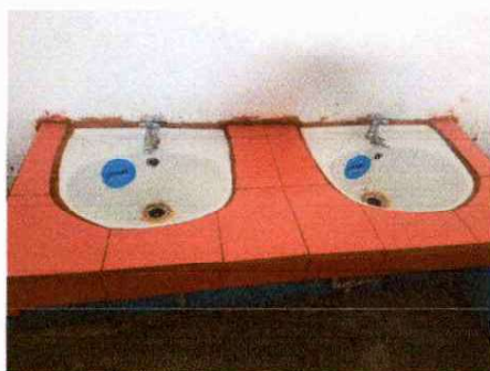
Foto 5: Construcción e instalación de azulejo e lavamanos y migitorio en el baño de los varones.
