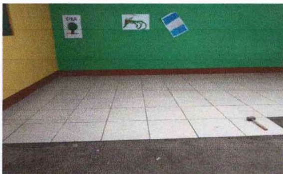
Foto 1: colocación de piso ceramico
