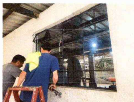
Foto 4: Cambio e instalación de vidrios en las ventanas de toda la escuela.
