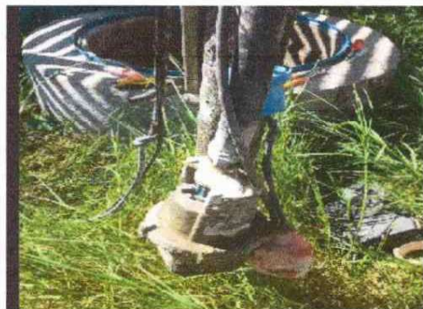
Foto 4: reparación de bomba de agua
