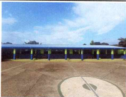
Foto 3: Cambio de techo en el módulo 2
