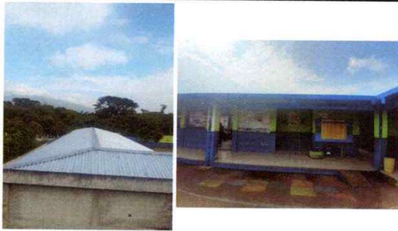
Foto 1: Lámina nueva y estructura metálica pintada
