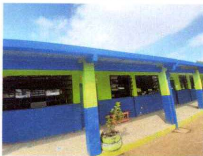
Foto 5: Estructura de techo finalizada
