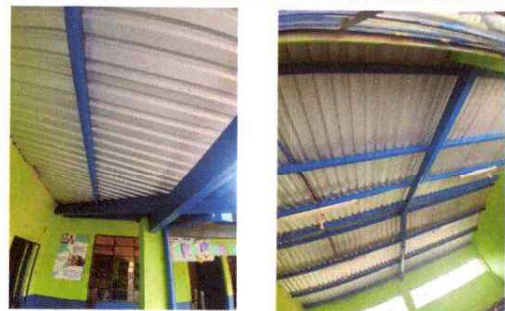
Foto 6: vista general de las aulas
