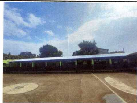
Foto 4: Cambio de techo en el módulo 1
