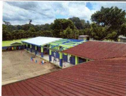
Foto 5: Cambio de techo en los módulos
