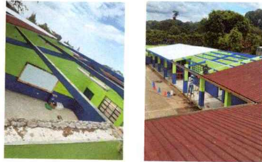
Foto 2: Cambio de la lámina del módulo 1
