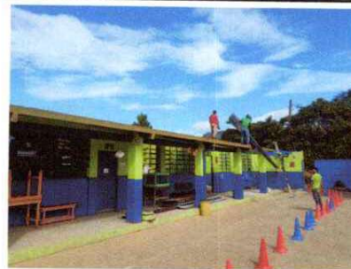
Foto 6: Desmontaje y cambio de lámina módulo 2
