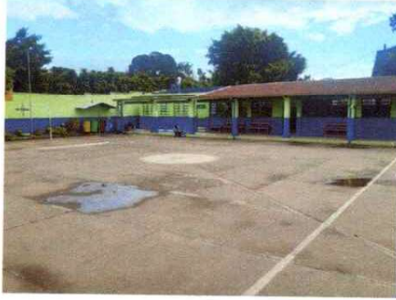
Foto 1: Inicio de cambio desmontaje de la lámina
