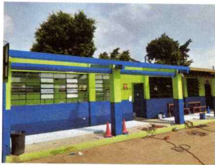
Foto 3: Mantenimiento a la estructura de metal de techo
