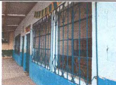
Foto 2: instalacion de vidrios
