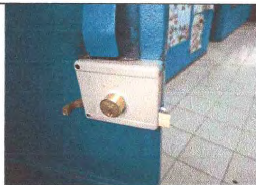
Foto 4: cambio e instalacion de chapas
