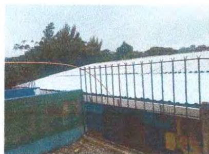
Foto 4: instalación de techo
