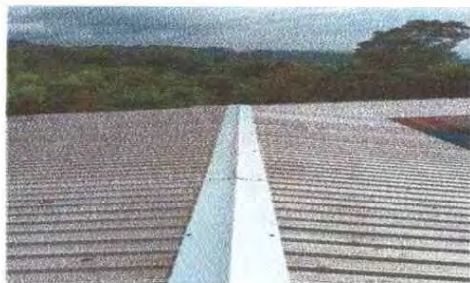
Foto1: instalacion de capotes finalizada
