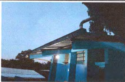
Foto 5: Instalación de canal de 7 metros con bajada de agua pluvial
