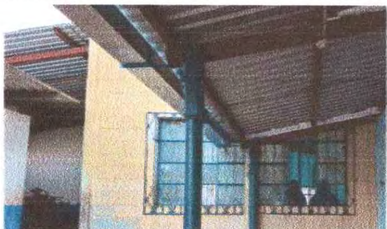
Foto 3 mantenimiento a ventanales y balcones
