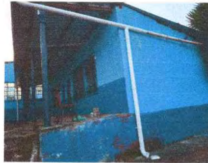
Foto 2: Instalación de canal con 2 bajadas de agua pluvial
