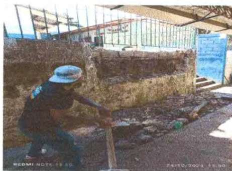
Foto 2: Demolición de muro de contension en mal estado
