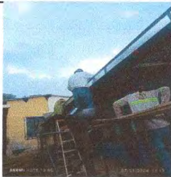
Foto1: Instalacion de Canal
