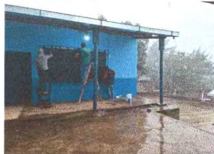
Foto 2: Aplicación de pintura
