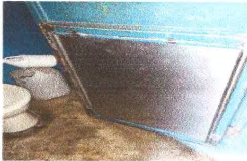
Foto 1: Reparación de puertas
