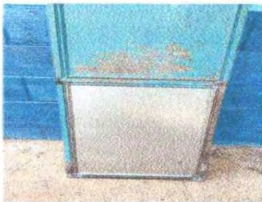
Foto 3: Reparación de puerta
