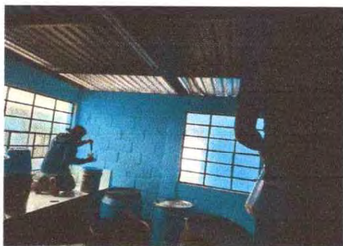
Foto1: Aplicación de pintura en cocina
