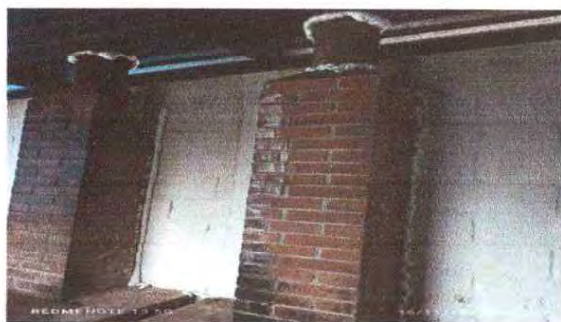
Foto 5: aplicacion de espuma para sellar filtraciones en chimeneas de cocina
