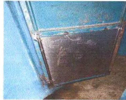
Foto 2: Reparación de puertas
