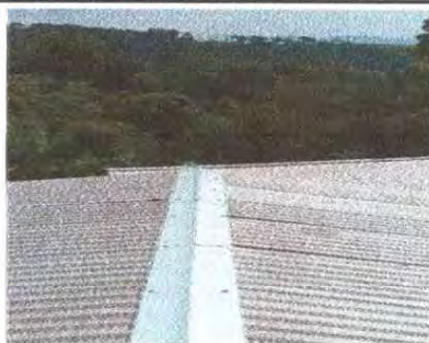
Foto 5: Instalación de capotes
