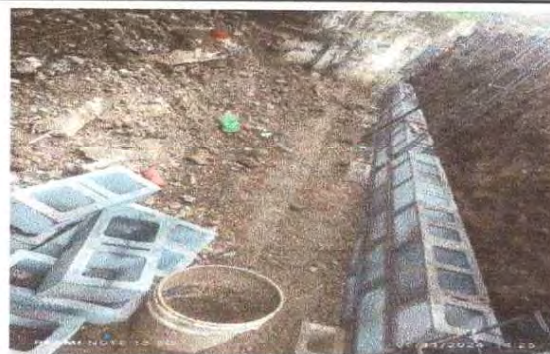
Foto 4: levantado de muro de contención
