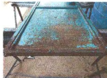
Foto 4: Reparación de puerta
