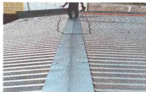
Foto 6: Instalación de capotes
