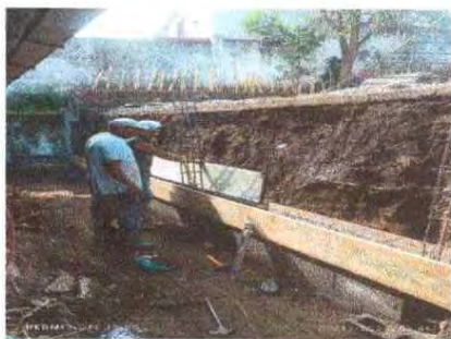
Foto 3: levantado de muro de contención
