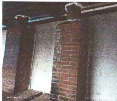
Foto 6: aplicacion de espuma para sellar filtraciones en chimeneas de cocina
