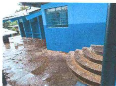
Foto 4: aplicación de pintura
