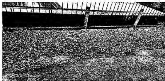
Foto 4: SUSTITUCION LOSA DE PATIO(12 m2 de 10 cm de espesor)
