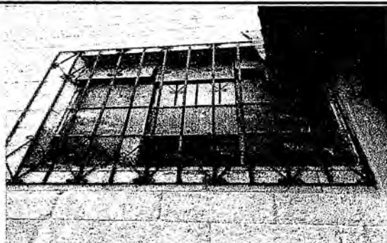
Foto 1: Reparación y mantenimiento de valcones e instalación de vidrios del área de salón principal
