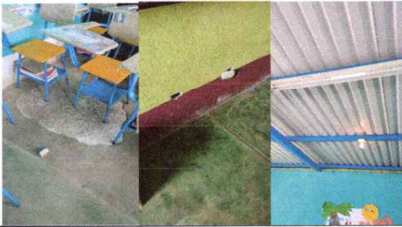
Foto1: Sustitucion de torta a piso de granito en las aulas, como la ilumacion de lamparas led, sustitucion de tomacorrientes e interruptores debido al daño que tienen y falta de electricidad en cada uno.
