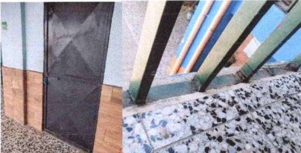
Foto 6: Sustitucion de puertas de metal en exteriores y chapa de baños de mujeres y hombres. Colocacion de muro de concreto para subir las barandas debido que se reposa el agua y se oxidaron.
