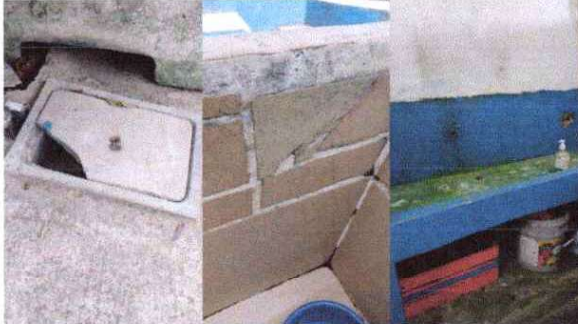
Foto 3: Instalacion de azulejos en muro de lavamanos y mijitorios en baño de hombres sustitucion de piso de torta a pido antidelizante, cambio de reposadera de cemento, cambio de llaves de chorros de agua potable
