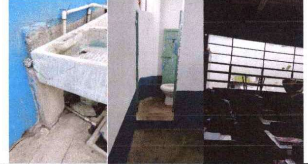
Foto 4: cambio de llaves de chorros en pila, instalacion de pilas, instalacion de azulejo en muros de los sanitarios de hombres y mujeres, instalacion de plancha de concreto, pintura en muros interior.
