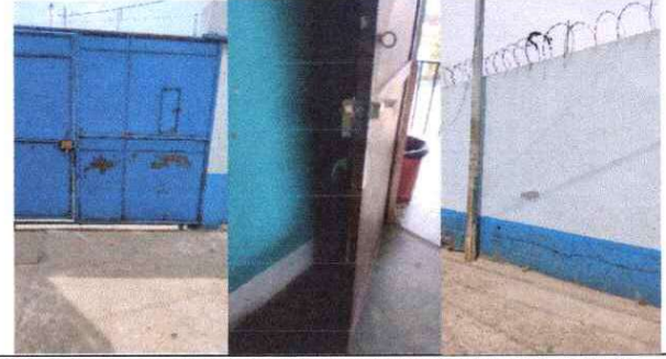
Foto 2: Pintura muros interiores, cambio de puertas de metal sanitarios, sustitucion de piso de cemento, sustitucion de lamparas, interruptores, mantenimiento de pintura en estructura del portón.
