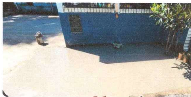
Área para pavimentar frente a las aulas de párvulos.
