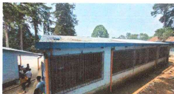
Área para colocación de canal 21 mts,
