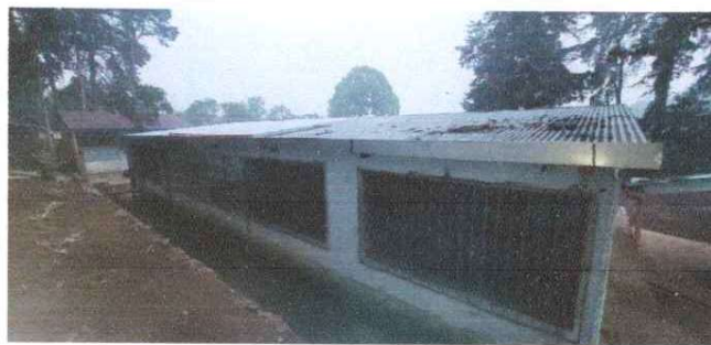
Área para colocación de canal 21 mts.
