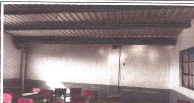
Foto 2: mantenimiento del canal segundo nivel
