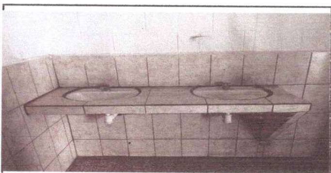
Foto 5: Llaves de baños instaladas
