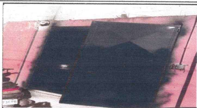
Foto 2: mantenimiento del porton entrada principal
