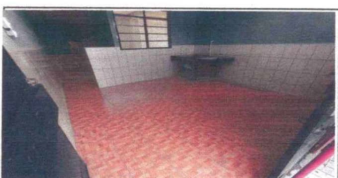
Foto 6: Instalacion de piso y azulejo ceramica en area de cocina
