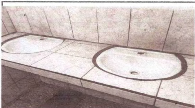
Foto 3: Cambio de llaves para lavamanos
