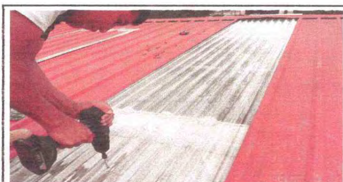
Foto 6: Sustitucion de lamina blanca laga luz en el area de sanitarios del segundo nivel
