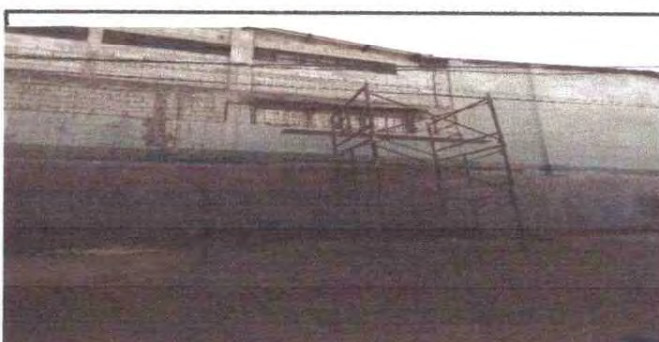
Foto 6: rezanar , columnas bigas y pegado de block parte exterior del establecimiento
