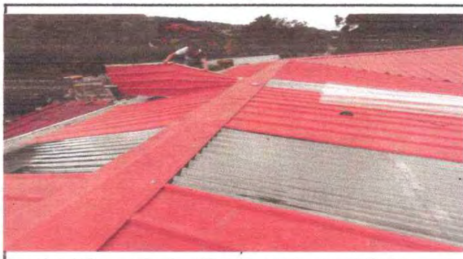
Foto 4: Sustitucion de lamina blanca traza luz
