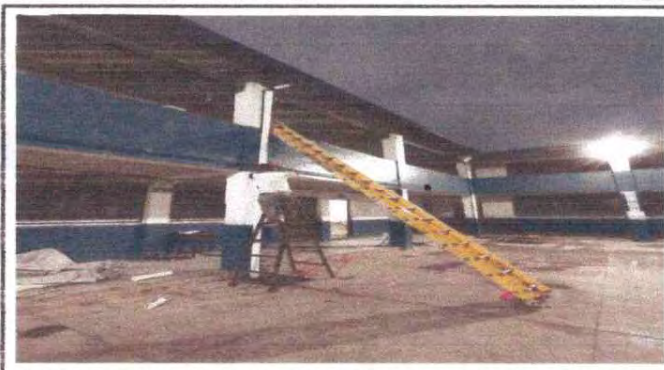
Foto 2: Sustitucion de tubos PVC color blanco de caida de agua p,luvial
