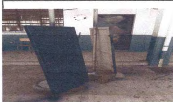
Foto 4 Pulido y pintado , cambio de pasadores puertas de los sanitarios
