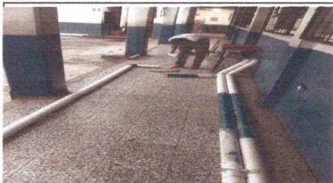
Foto1: Sustitucion tubo PVC color blanco de caida de agua pluvial
