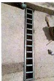
Foto 6: SE REALIZANDO LA CUNETA PARA DEJAR CAIDA DE AGUA DE SANITARIOS QUE TERMINE EN EL DRENAJE.
