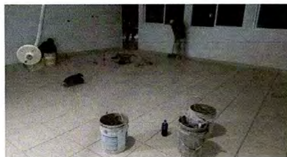
Foto 4: COLOCACIÓN DE PISO TERMINADO.
