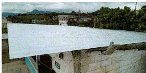
Foto 1: COSTANERA E INSTALACION DE LAMINA TROQUELADA TERMINADA.
