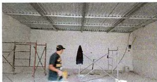
Foto 5: COSTANERAS GALVANIZADAS EN EL SALON DE 1RO, PRIMARIA LAMINA TROQUELADA Y COSTANERAS TERMINADO.
