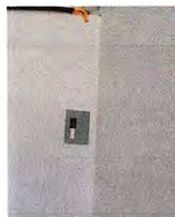
Foto 4: se finalizan la instalacion de de luz como caja.
