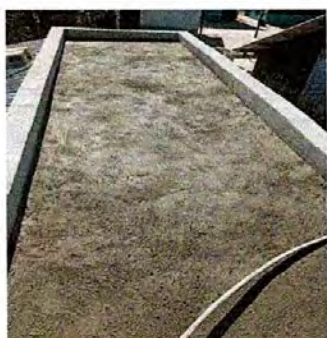
Foto 3: SE FINALIZO DESNIVEL DE AGUA EN LA TERRAZA DE LOS SANITARIOS DE LA J.M.
