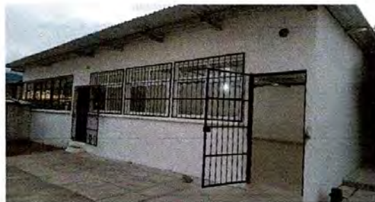
Foto 2: SE TERMINO EL REPELLO DE AMBOS SALONES
