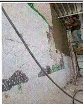
Foto 3: PICADO DE PAREDES DEL SALON DE 1RO. PRIMARIA
