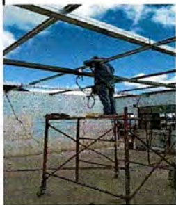
Foto 1: 1 DIRECCIÓN DE LA TARDE PINTADO DE COSTANERAS Y COLOCACION DE LAMINA TROQUELADA
