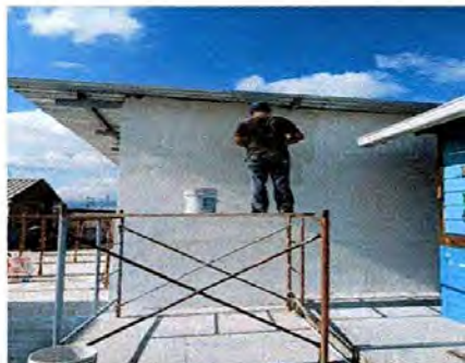
Foto 2: SE ESTA REPELLANDO EL LADO LATERAL DEL SALO DE 10. PRIMARIA
