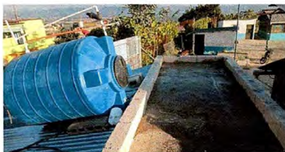
Foto 3: SE ESTA REALIZANDO EL DESNIVEL DE AGUA EN LA TERRAZA DE LOS SANITARIOS DE LA J.M.
