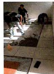
Foto 4: COLOCACIÓN DE PISO CERAMICO DE 1RO PRIMARIA, PEGAMIX,CAPA GRUESA Y SISA.
