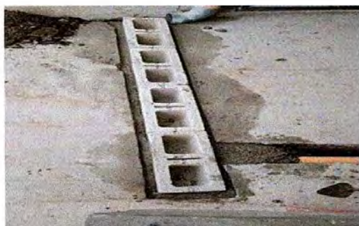
Foto: SE REALIZANDO LA CUNETA PARA DEJAR CAIDA DE AGUA DE SANITARIOS QUE TERMINE EN EL DRENAJE.
