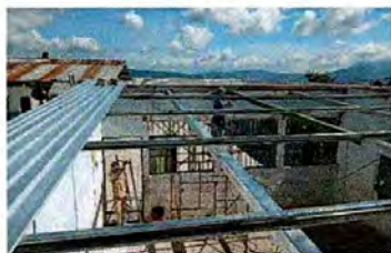
Foto 1: 1 DIRECCIÓN DE LA TARDE PINTADO DE COSTANERAS Y COLOCACION DE LAMINA TROQUELADA
