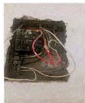
SE COLOCO BASE PARA PLAFORNERA Y CAJA CON FLIPONES
