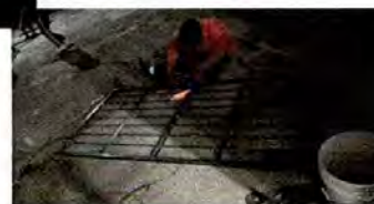
Foto 2: 2 SALÓN 1RO PRIMARIA J.M. DESISTALACION DE VENTANAS Y ELABORACION DE PUERTA BARANDAL.
