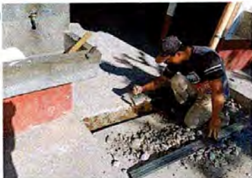
Foto 3: SE COLOCARA UNA FIALA DE BLOCK EN EL AREA DE LA TERRAZAS DE LOS SANITARIOS J.M. Y LUEGO UN DESNIVEL CIN TUVOS TENER UNA CAIDA DE AGUA FLUVIAL
