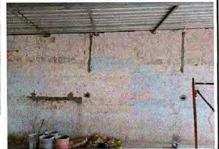
Foto 4: CAMBIO DE CAJA E INSTALACION DE TUBERIA PARA LOS FOCOS.
