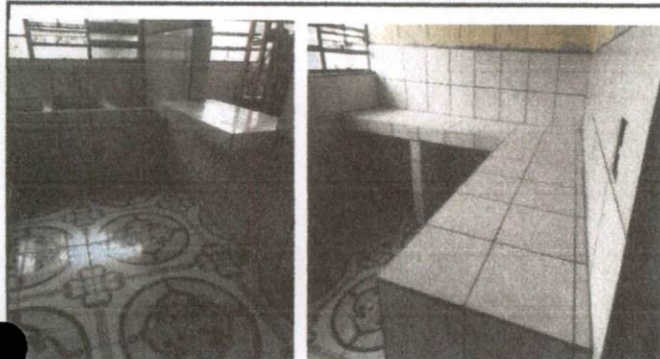
Foto1: Área de cocina remozado, piso, gavinete, pileta, puerta y pasamanos.
