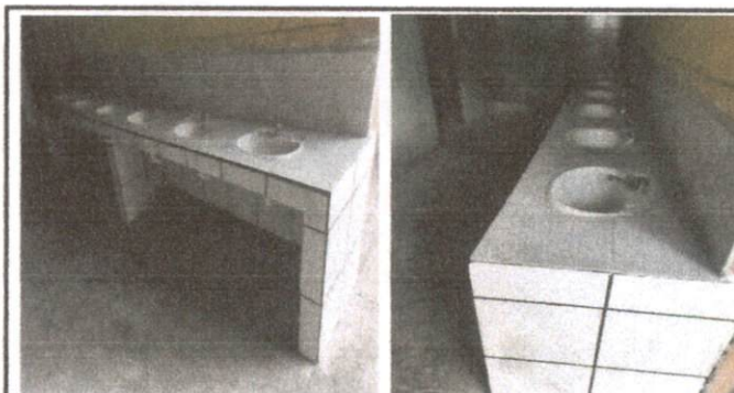
Foto 6: Instalación de 6 lavamanos tipo gavinete.
