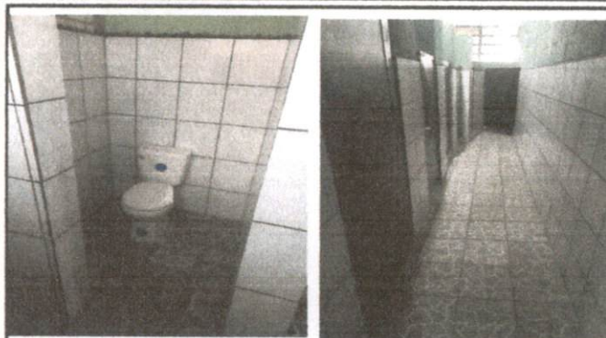
Foto 2: Área de baños niñas remozado, baños nuevos, piso y puertas.
