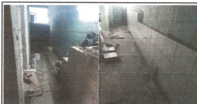
Foto 4: Proceso de mejoramiento de baños niños, piso, baños nuevos, mitorio y pintado de puertas.
