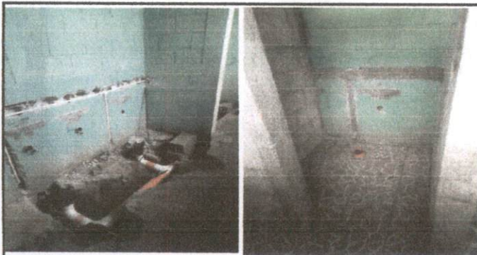
Foto 3: Proceso de instalación de 2 baños niñas, pared de división y puertas.
