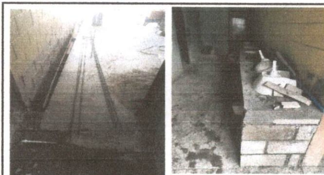
Foto 6: Proceso de Construcción de lavamanos tipo gavinete.
