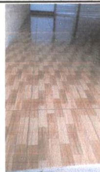
Foto 6: Piso aula No 1 modulo 1 planta alta.
