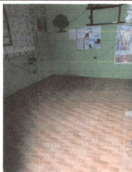
Foto 11: Piso direccion del establecimiento, modulo area administrativa.
