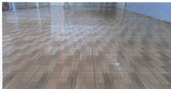
Foto 7: Piso aula No 2 modulo 1 planta alta.
