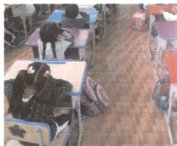
Foto 10: Piso aula no.2 modulo de preparatoria.
