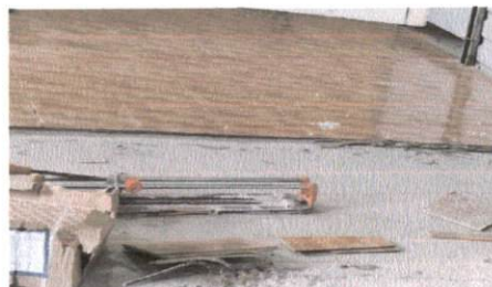
Foto 12: Piso, bodegas, direccion modulo area administrativa.
