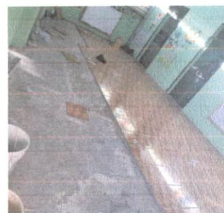
Foto 10: Piso aula no.2 modulo de preparatoria.
