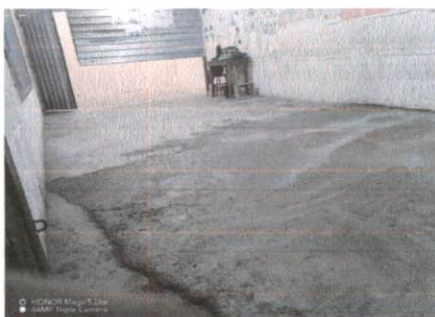
Foto 5: Piso aula No 3 modulo 1 planta baja.
