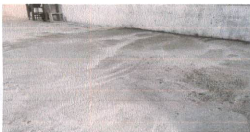
Foto 15: Piso, bodegas, direccion modulo area administrativa.
