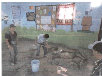
Foto 9: Piso aula No 2 modulo 3 planta baja.
