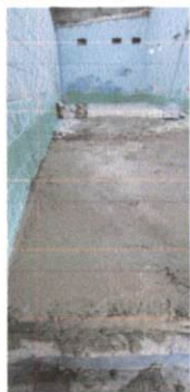
Foto 3: Piso aula No 1 modulo 1 planta baja.
