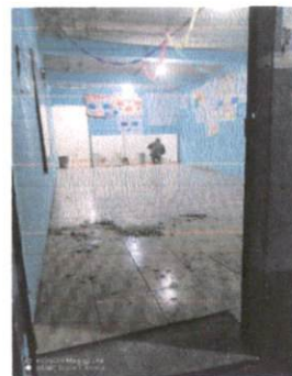
Foto 4: Piso aula No 2 modulo 1 planta baja.
