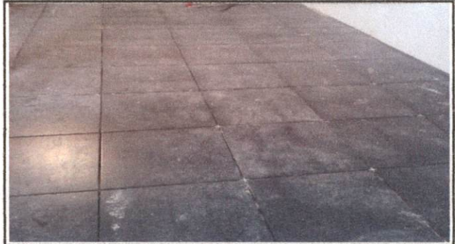
Finalización de colocación del piso
