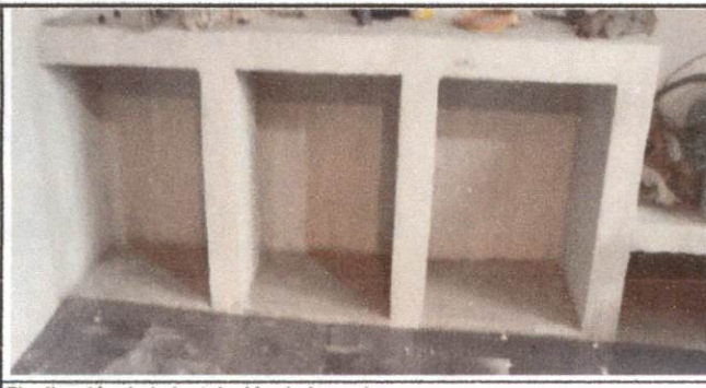
Finalización de la instalación de la cocina
