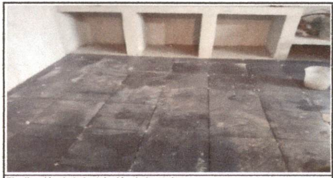
Finalización de la instalación de la cocina
