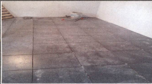
Finalización de colocación del piso
